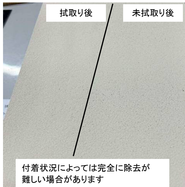
【左側のみ中性洗剤＋スポンジで除去後】
